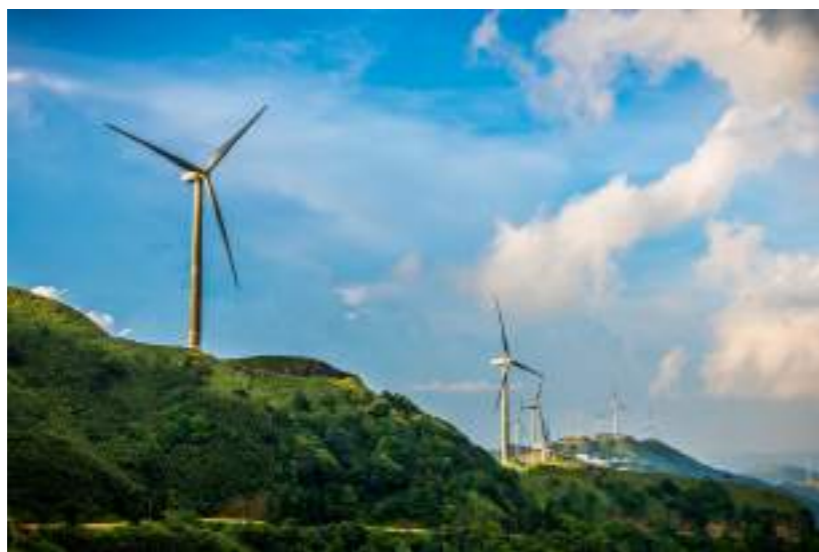
广西北部湾银行支持建设的玉林大容山景区风力发电厂
