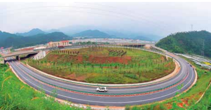
中国农业银行广西区分行投放 30 亿元贷款支持资源至兴安高速公路，联通桂林至张家界两大旅游城市，形成贯穿连接具有世界影响力的张家界砂岩地貌、八角寨（崀山）丹霞地貌、桂林喀斯特地貌的大旅游通道
